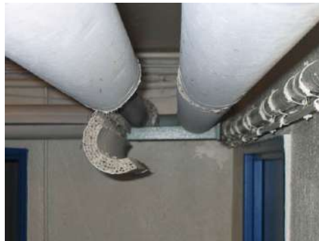
Calorifugeage en PANOCCELL
