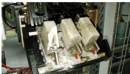
Panneaux disjoncteur sectionneur
