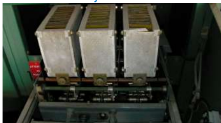
Panneaux disjoncteur sectionneur
